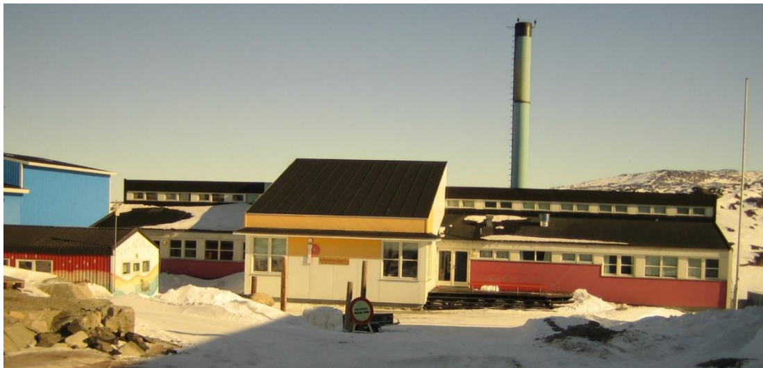
PI/SPS, tidligere facade
