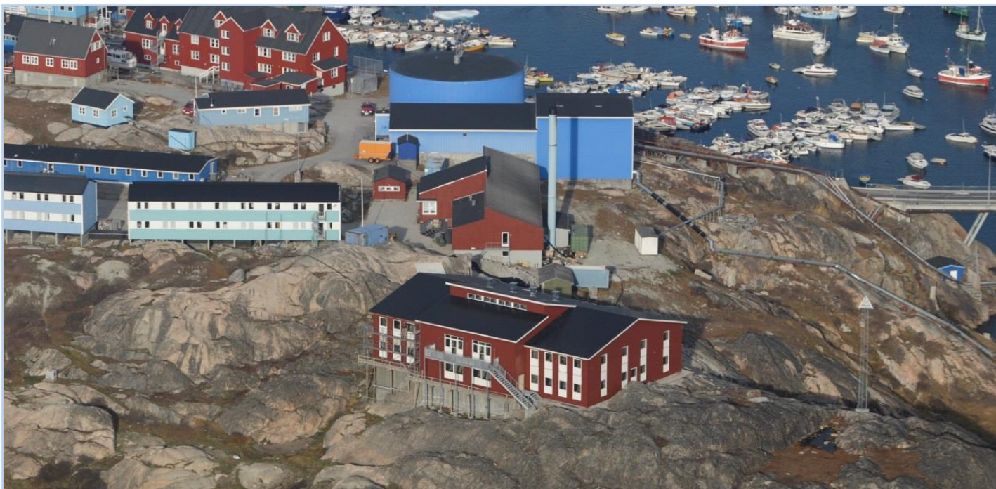
Den nyere bygning af PI/SPS
